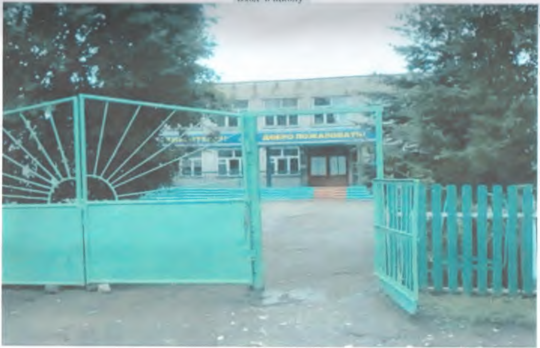
Вход в школу
