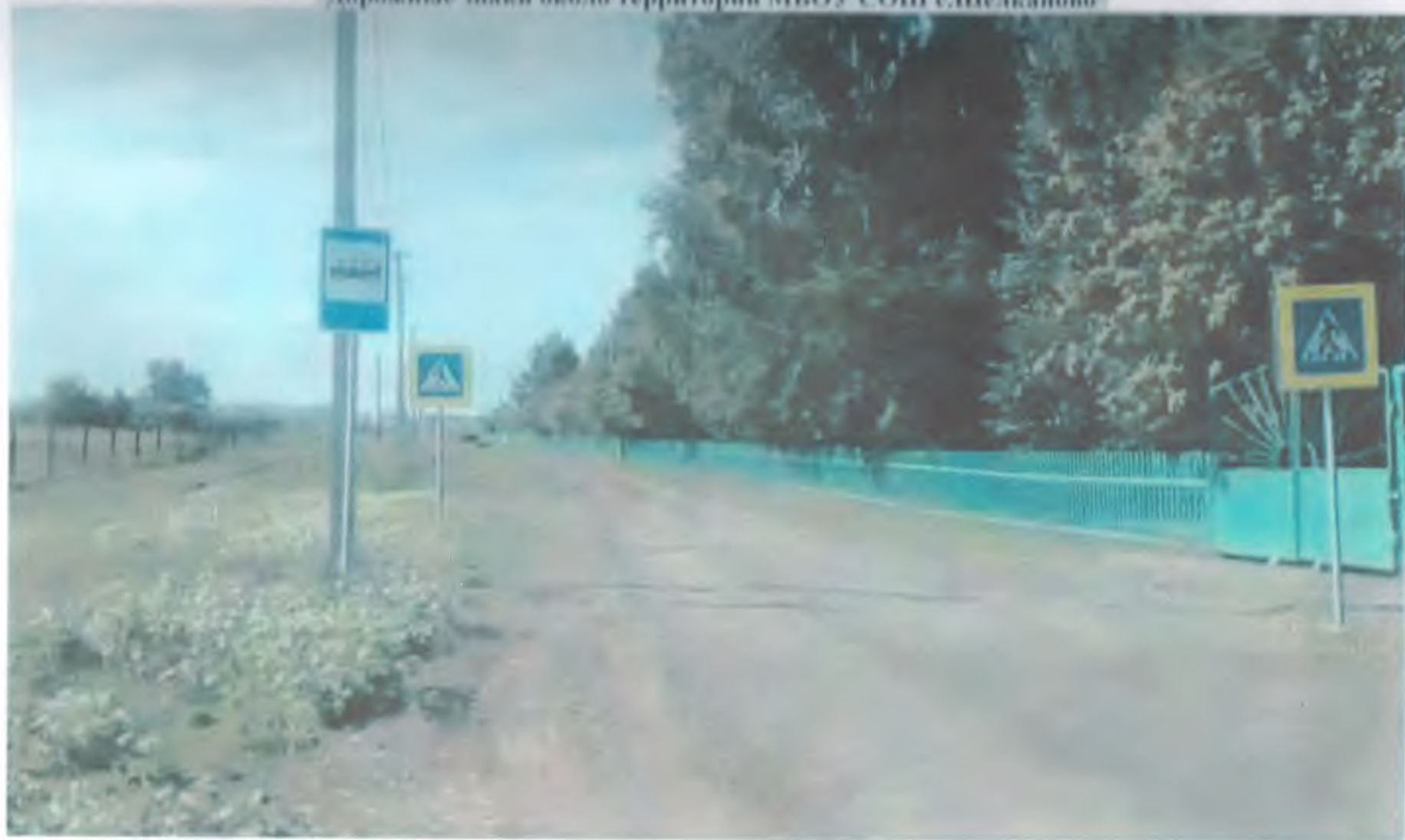
Дорожные знаки около территории МБОУ СОШ с.Шелканово
